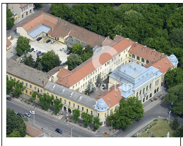
A Városháza környezete (a Kossuth tér felől)
